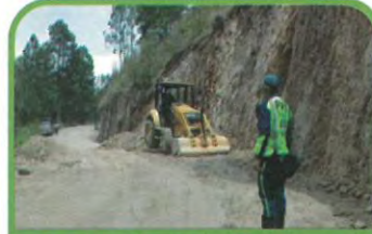
Makichá, aldea Xequemeyá, ampliación de carretera.
