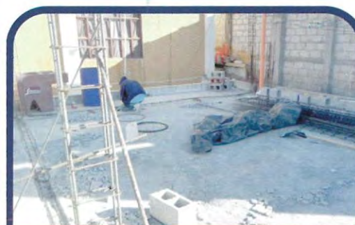
Mejoramiento edificios municipales de Momostenango para el año 2018 (Q150,000.00)
