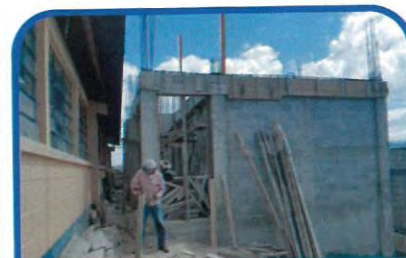
Ampliación Escuela Primaria del Centro Caserío Choxacol, aldea Tunayac, Momostenango (Q390.000.00).
