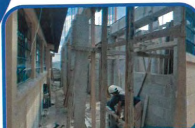
Construcción Instituto Básico Paraje Chicorral, aldea San Antonio Pasajoc, Momostenango (Q885.000.00)
