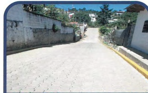
Mejoramiento calle 4a. en 4a. avenida zona barrio Santa Isabel, Momostenango (Q315,000.00).
