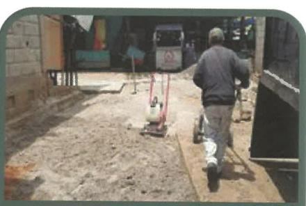
Pavimentación en el interior del mercado sobre el lugar donde se colocó la tubería y donde se construyeron las cajas de unión dentro del mercado.
