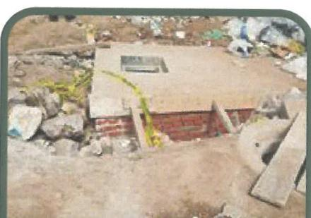
Construcción de la caja de unión de la tubería existente y la tubería nueva
