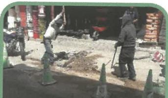
Reparación De Fugas De Agua Potable Municipal Por Fallas En Los Sistemas.
