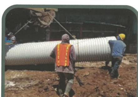
Colocación de la tubería de drenaje de 36 pulgadas
