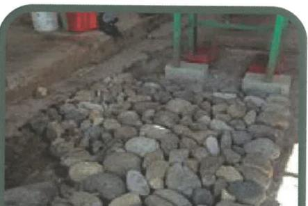
Empedrado fraguado después de la colocación de la tubería y relleno controlado sobre la misma.
