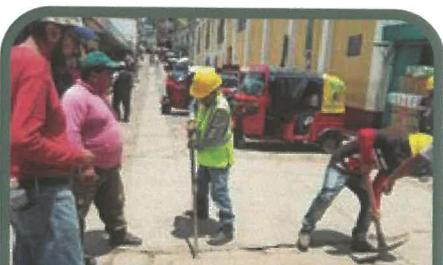
Inicios del proyecto, inspección de la tubería existente para determinar la pendiente de la nueva tubería y la profundidad de la zanja a realizar, zanjeado para la colocación de la tubería de 36 pulgadas de diámetro.
