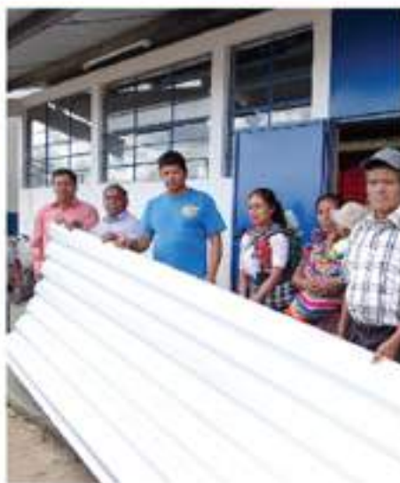
Reparación, techo de escuela oficial rural mixta, Caserío Canquixaja.
