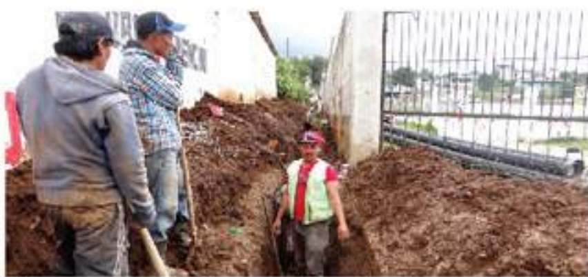
Mejoramiento del sistema drenaje 6a. calle zona 3.
