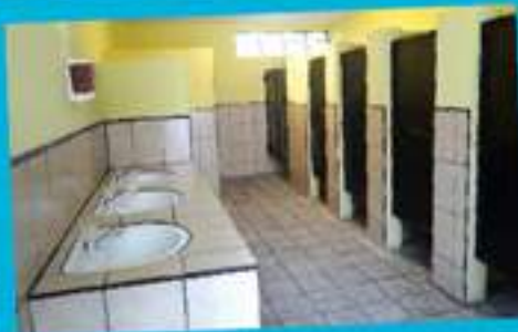
Remodelación de servicios sanitarios del parque central de Momostenango.
